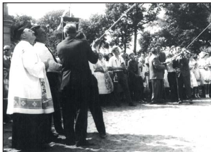
Vytahování zvonů na věž
