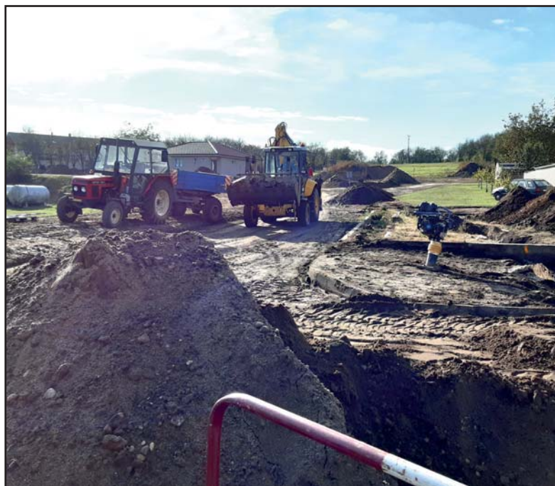
Lokalita v Trnkách, výstavba inženýrských sítí
