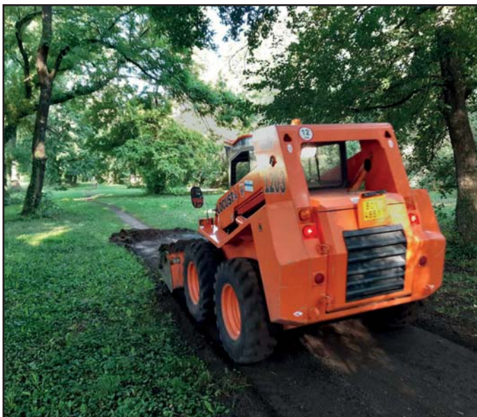
Práce na rozšiřování cesty
