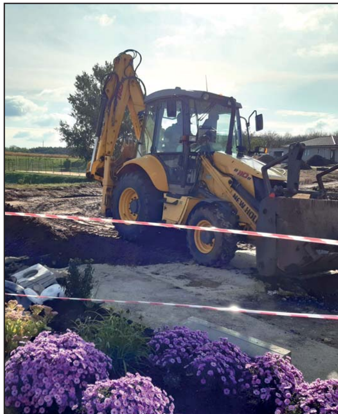
Budování ulice V trnkách
