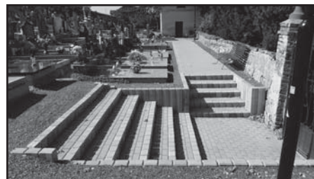
Hřbitov - schodiště a osvětlení 2017
