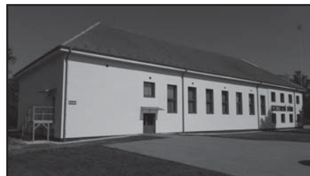
Kulturní dům přístavba a zateplení 2018
