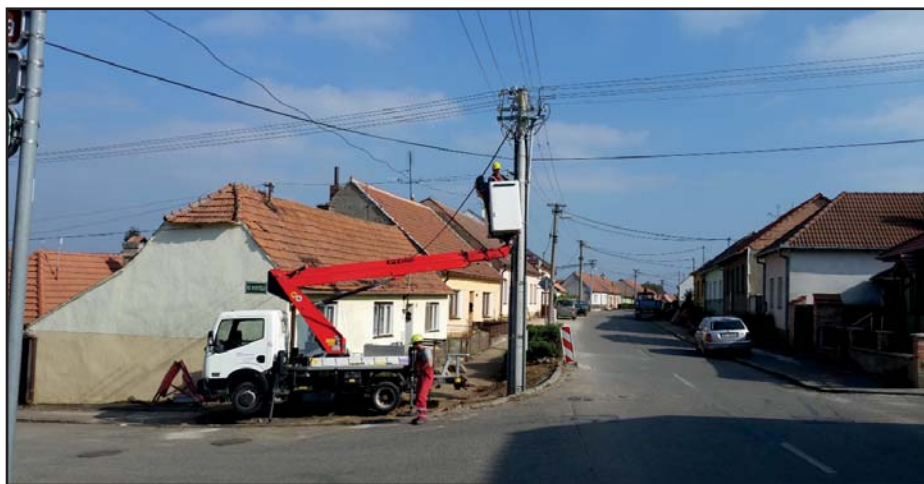
Ulice Hlavní před kabelizací 2017. Foto archiv redakce
