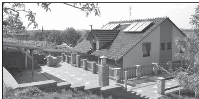
Pohled na terasu.
