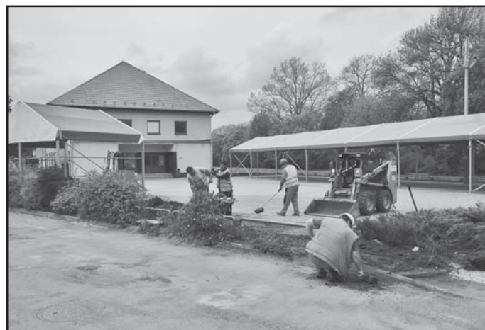
Stavební práce před KD.
