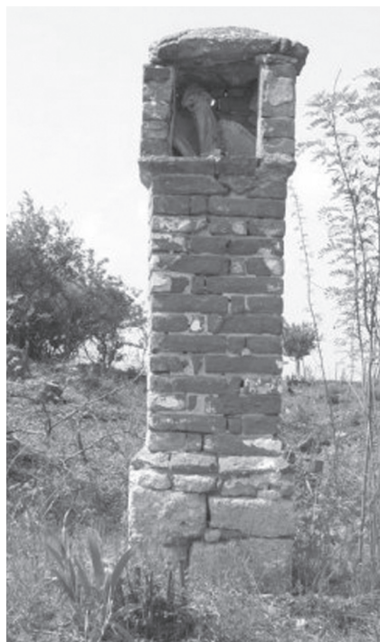
Boží muka před a po opravě.
