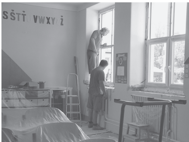
Pracovníky, kteří se postarali o výměnu oken v základní škole jsme zastihli při posledních dodělkách. Foto: Zuzana Nešporová
